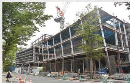
来春竣工に向けて建設工事が進むミルハス。 手前が中ホール、奥が大ホール
