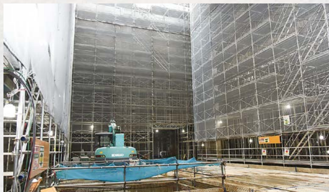
中ホール内部の工事の様子。写真右側の足場の奥に客席を設け、手前の足場のない一面が舞台となる
